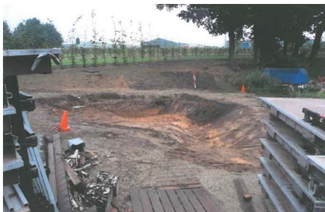
Op afbeelding 5 en 6 is de uiteindelijke saneringsput weergegeven.
