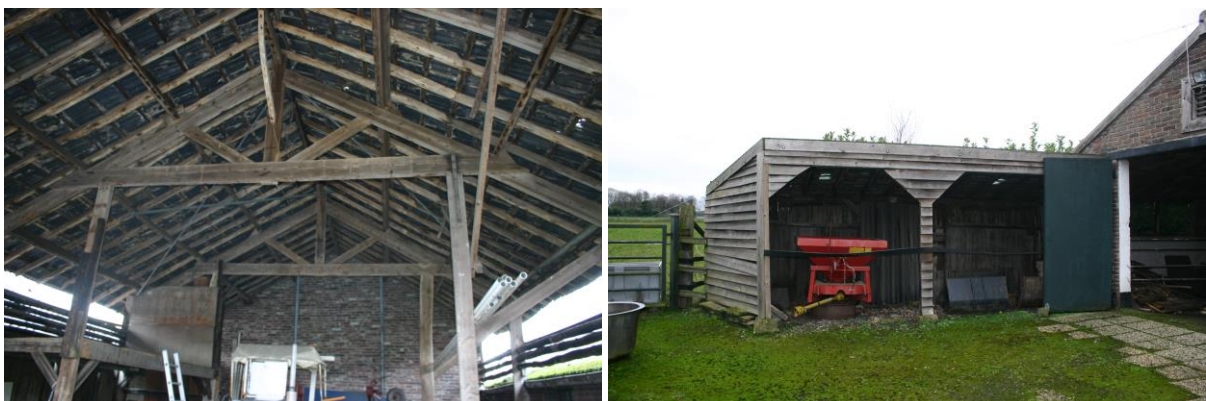
Figuur 4.4.2. De bijgebouwen in het plangebied zijn alle volledig enkelwandig. Hier twee voorbeelden.
