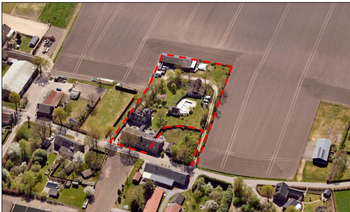
Afbeelding 2. Luchtfoto van de locatie Loo 14a te Panningen
